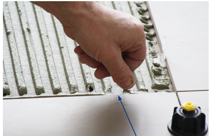
Gewindelasche unter die Fliese eindrücken
